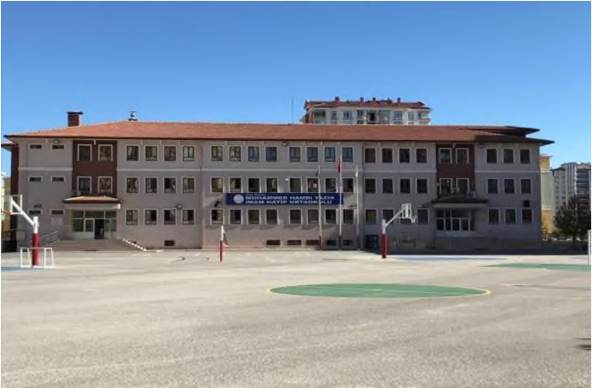
Burdur Çavdır Muhammed Hamdi Yazır(16 Derslikli) İmam Hatip Ortaokulu Yapım İnşaatı
