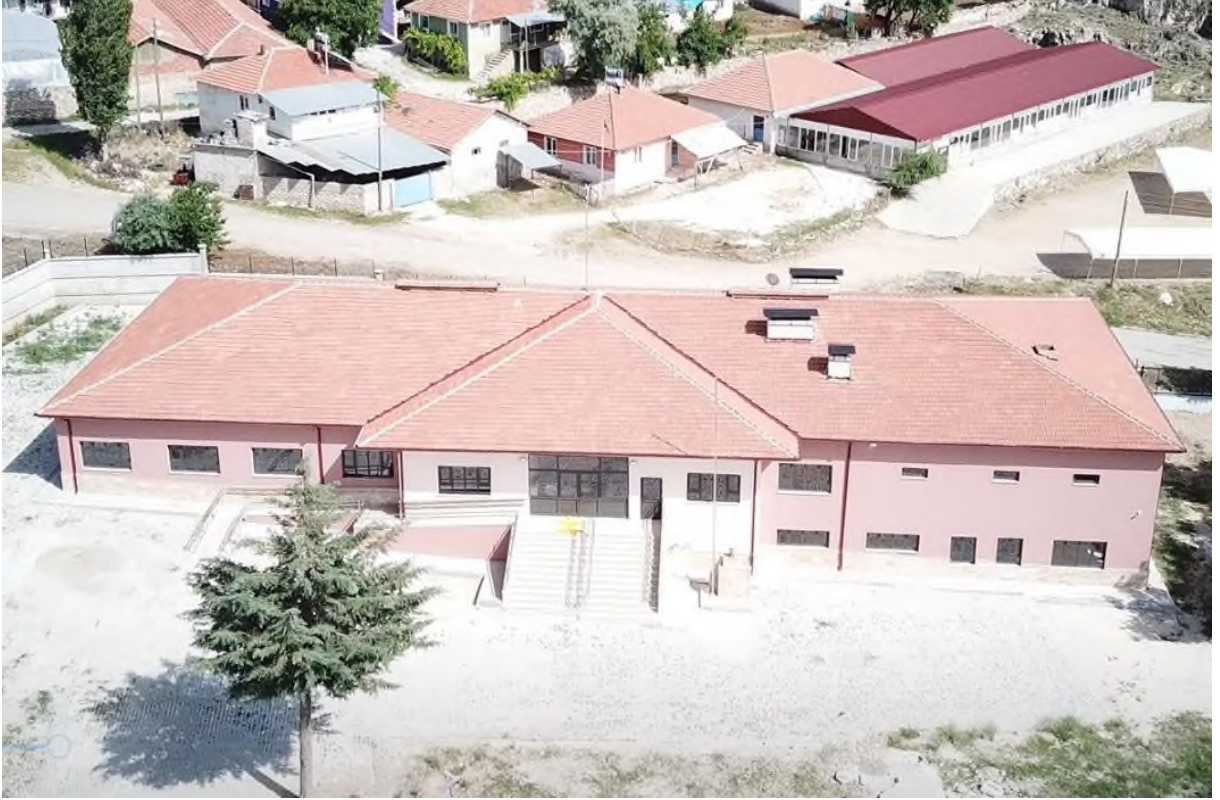
Burdur Merkez Çatağıl İ.Ö.Okulu İkmal İnşaatı
