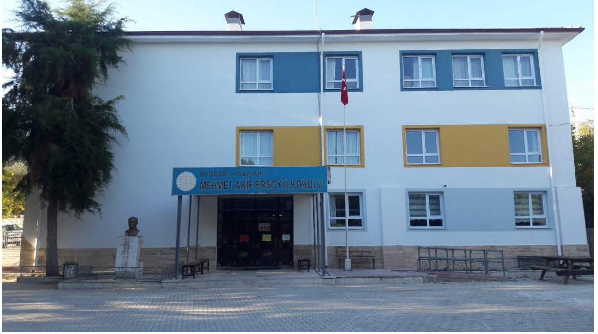
Burdur Ağlasun Mehmet Akif Ersoy İlkokulu Deprem Güçlendirme Çalışmamız
