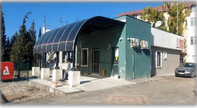
Burdur Altınyayla 112 ASH Binası İnşaatı Yapım İşi
