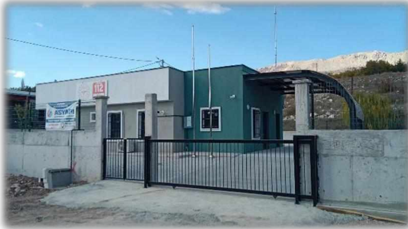
Burdur Ağlasun 112 ASH Binası İnşaatı Yapım İşi
