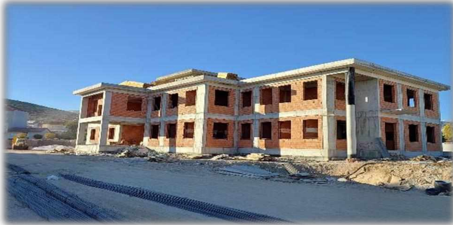
Karamanlı Polis Merkezi Amirliği İnşaatı Yapım İşi
