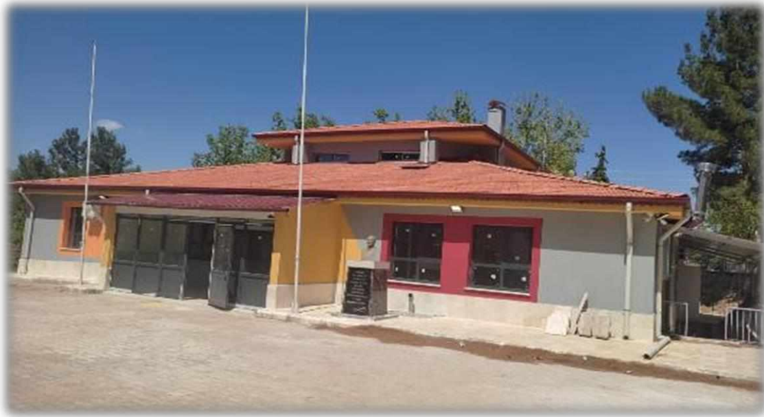
Burdur Çavdır Anaokulu Güçlendirme Yapım İşi
