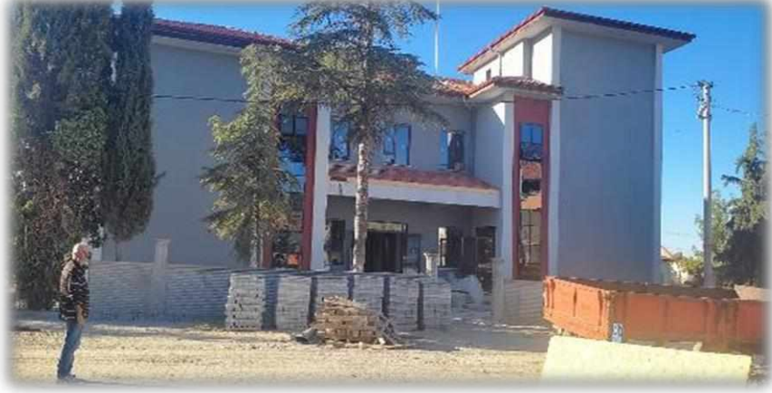
Burdur Merkez Kemer ASM+TSM İnşaatı Yapım İşİ
