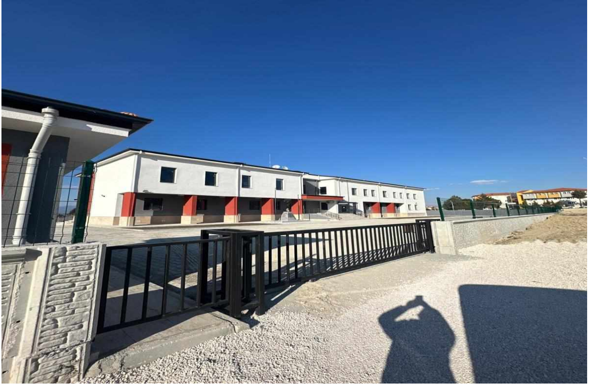
Burdur Merkez Rehberlik ve Araştırma Merkezi Yapım İşı
