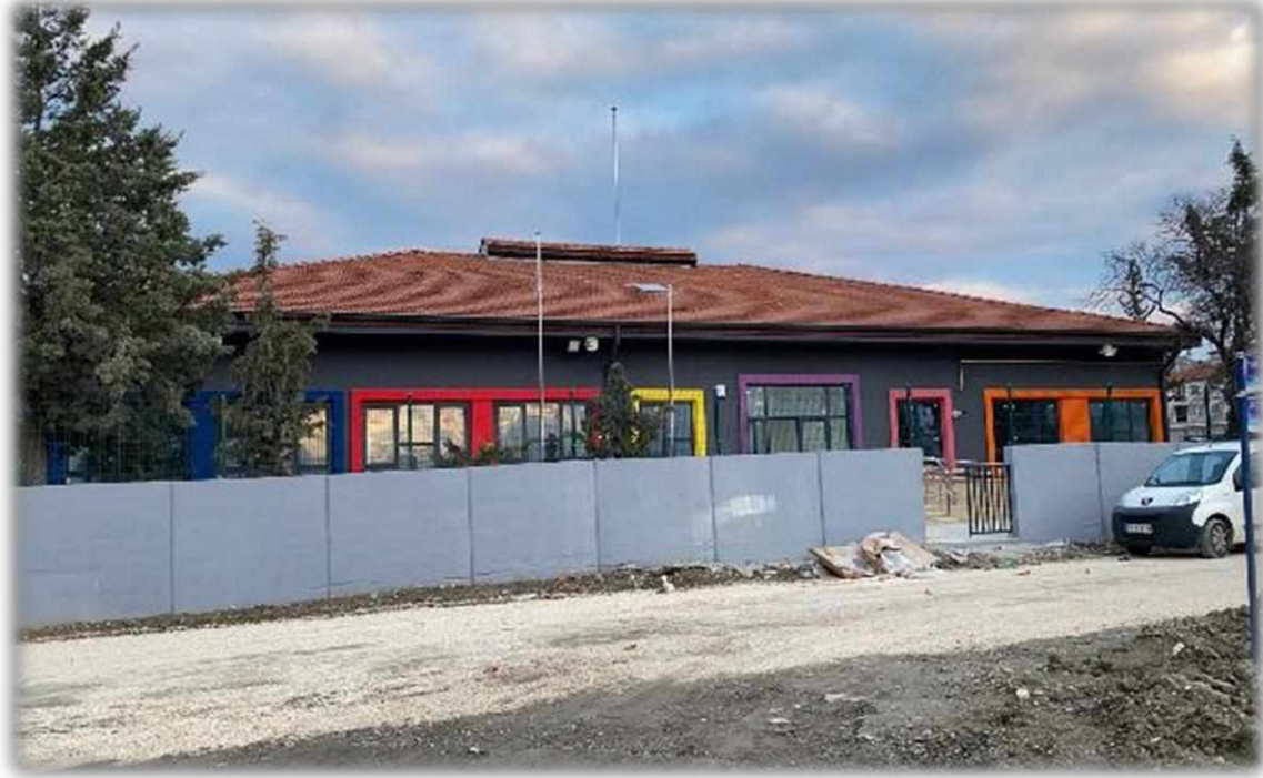
Burdur Merkez Bađlar Anaokulu Yapım İŖi
