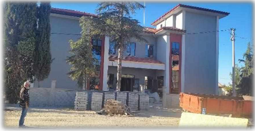
Burdur Merkez Kemer ASM+TSM İnşaatı Yapım İşİ
