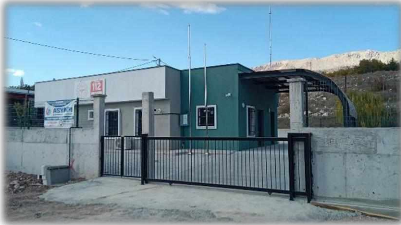
Burdur Ağlasun 112 ASH Binası İnşaatı Yapım İşi
