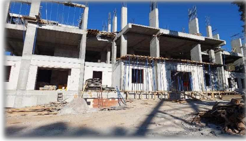
Altınyayla Hükümet Konağı ve İlçe Emniyet Amirliği Hizmet Binası Yapım İşİ
