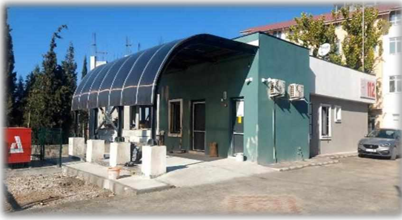
Burdur Altınyayla 112 ASH Binası İnşaatı Yapım İşi
