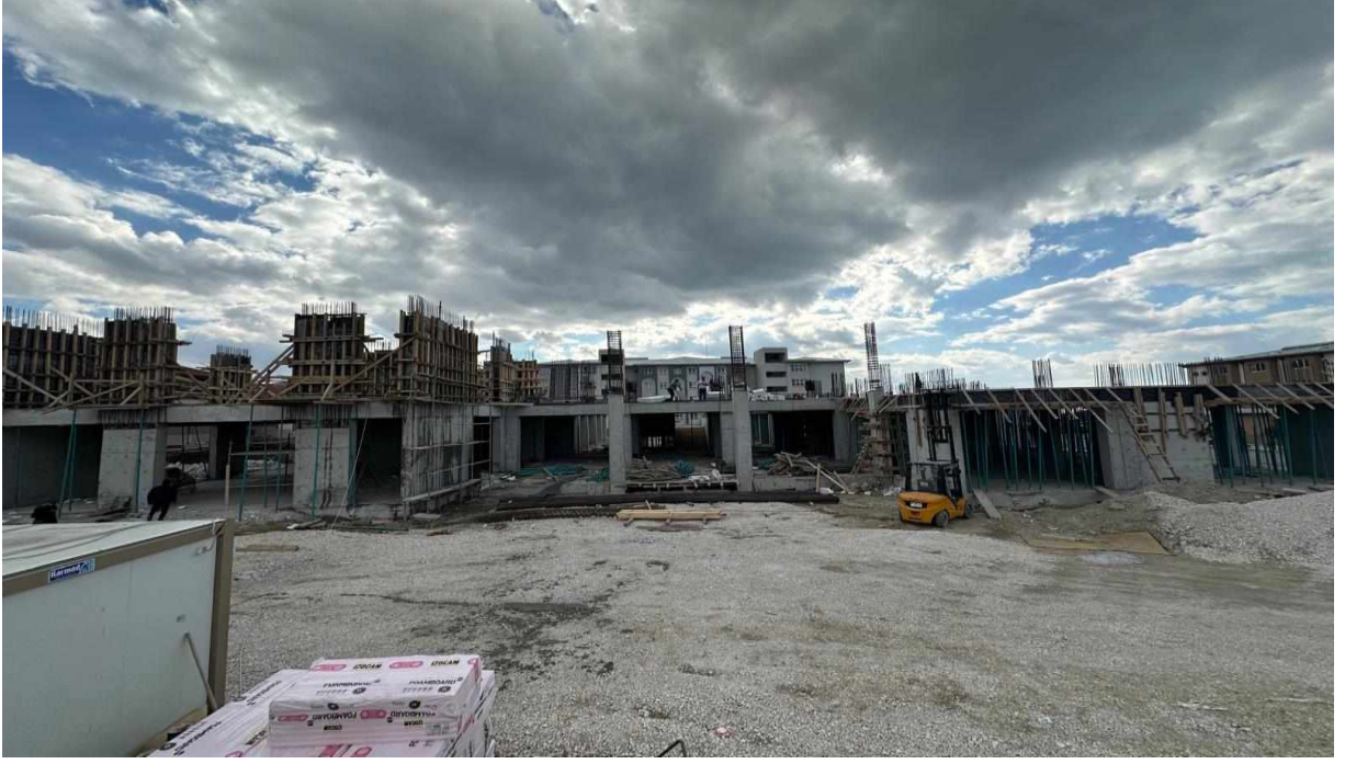
Burdur Merkez16 Derslikli Özel Eğitim Uygulama Binası Yapım İŖi
