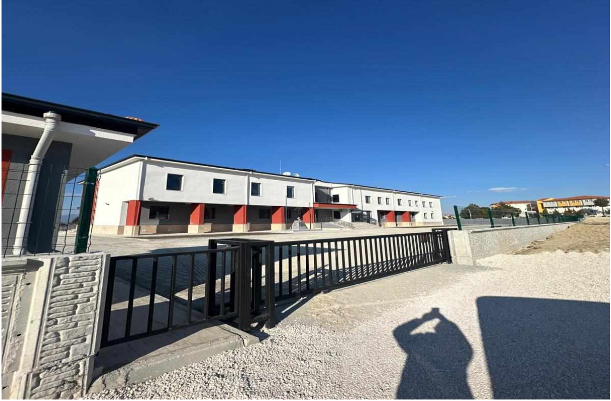
Burdur Merkez Rehberlik ve AraŖtırma Merkezi Yapım İŖi
