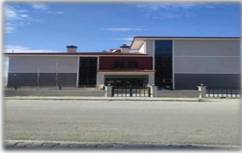
Merkez 4 Nolu (TOKİ) Aile Sağlığı Merkezi (7-8 AHB) ve 112 ASH Binası İnşaatı Yapım İşi
