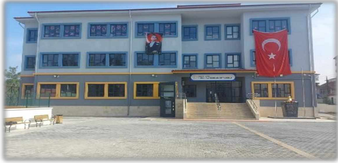
Burdur Merkez Türk Hava Kurumu 16 Derslikli Ortaokulu Yapım İŐi
