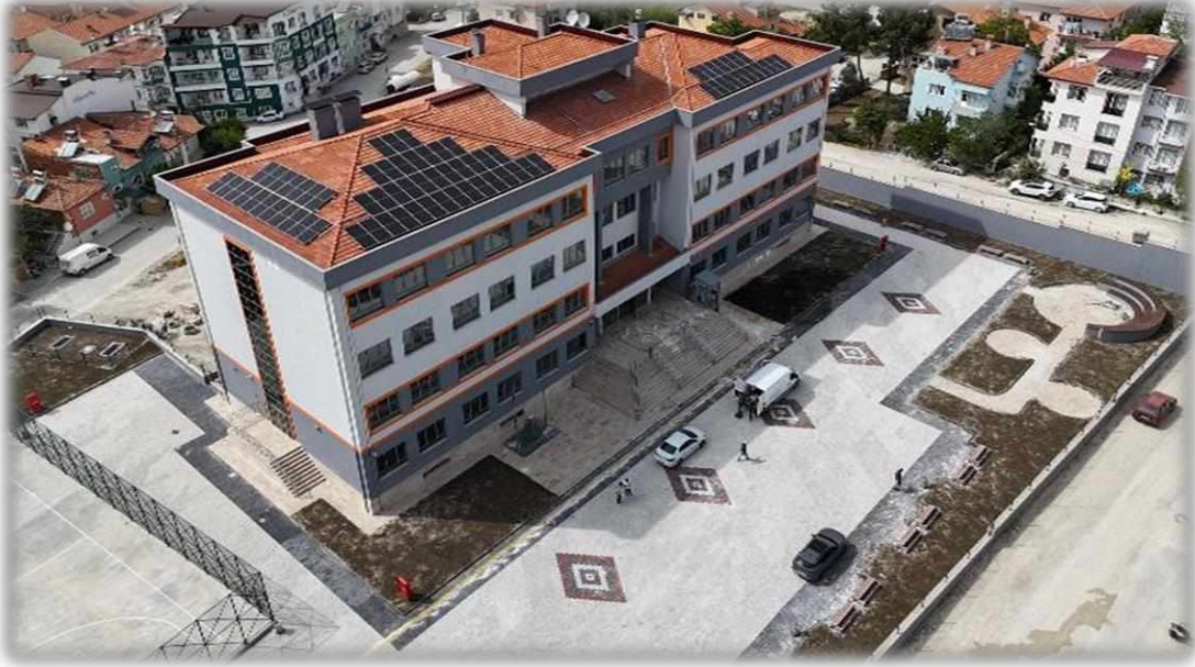
Burdur Merkez Kayışzade Hafız Osman Ortaokulu Yapım İŖi
