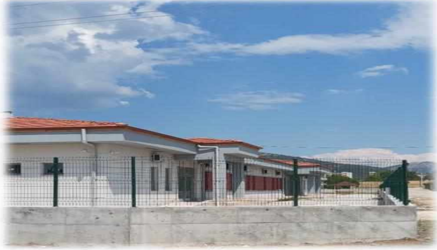
Bucak Barbaros Aile Saęlık Merkezi + 112 ASHİ Yapım İnşaatı İşİ
