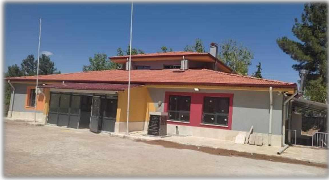
Burdur Çavdır Anaokulu Güçlendirme Yapım İŐi
