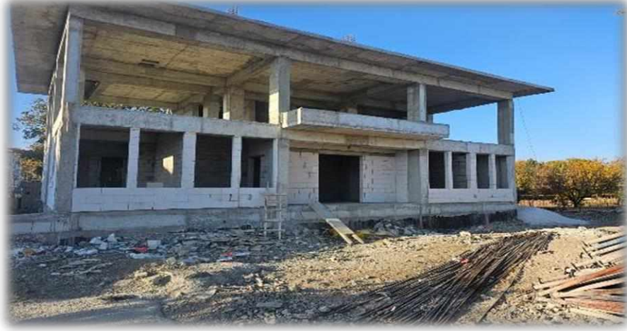
Yeşilova İlçe Emniyet Amirliği Hizmet Binası Yapım İşi
