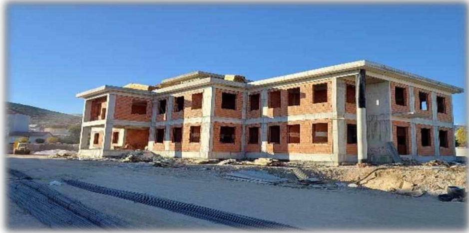
Karamanlı Polis Merkezi Amirliği İnşaatı Yapım İşi
