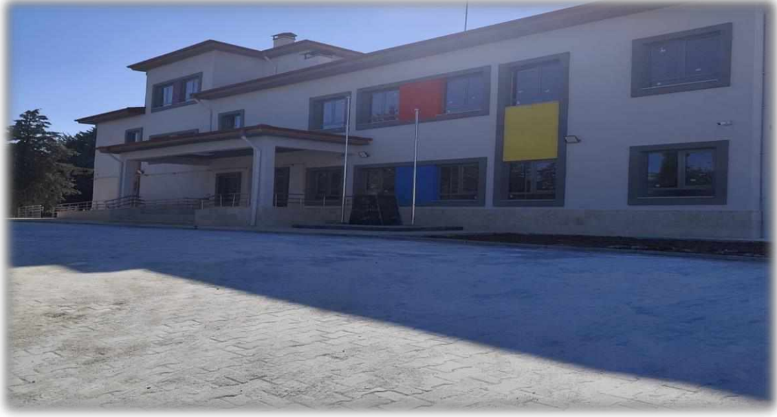
Burdur Merkez Özgür Mahallesi 6 Derslik Anaokulu Yapım İŖi
