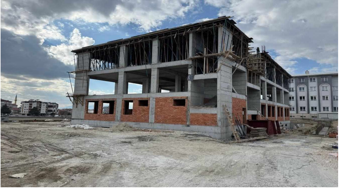
Burdur Merkez 16 Derslikli İbn-i Sina Mesleki ve Teknik Anadolu Lisesi Yapım İŖi
